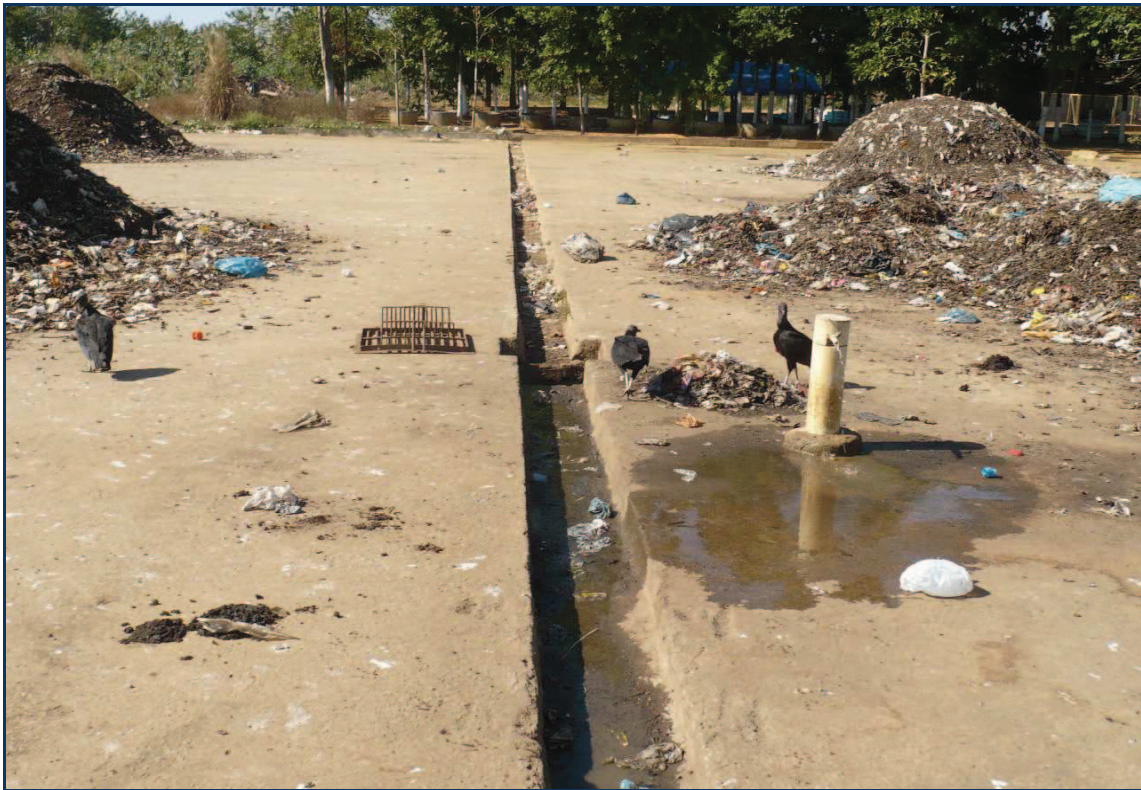
IMAGEM 36: Dreno da estação de compostagem. Coleta do chorume gerado pelo lixo, em 24 jul. 2008.
