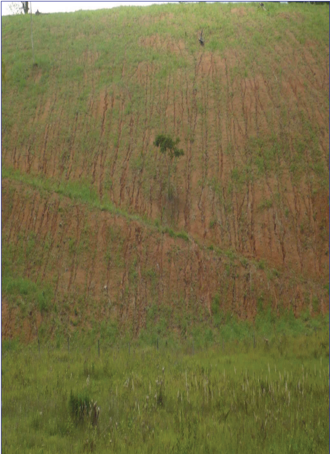
IMAGEM 23: Intenso escoamento superficial, o qual intensifica o processo erosivo.
