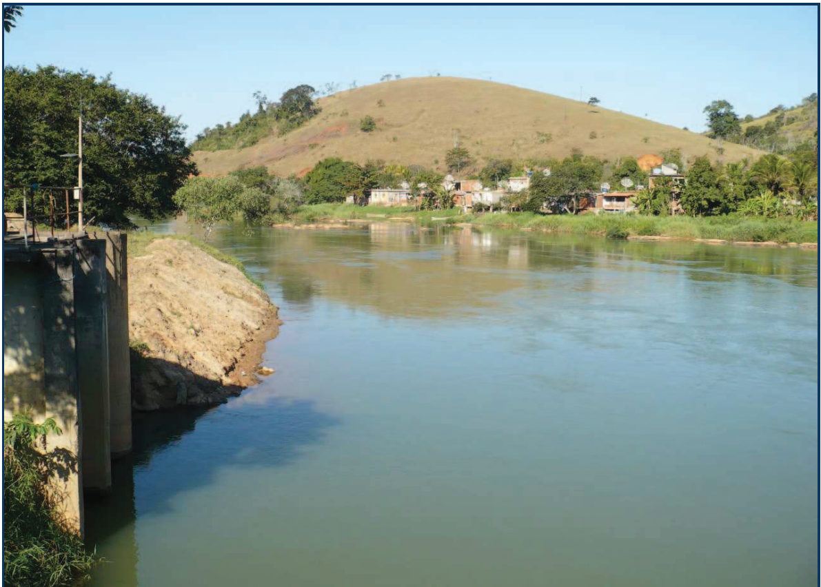
IMAGEM 4 – Captação da água as margens do Rio Pomba.
