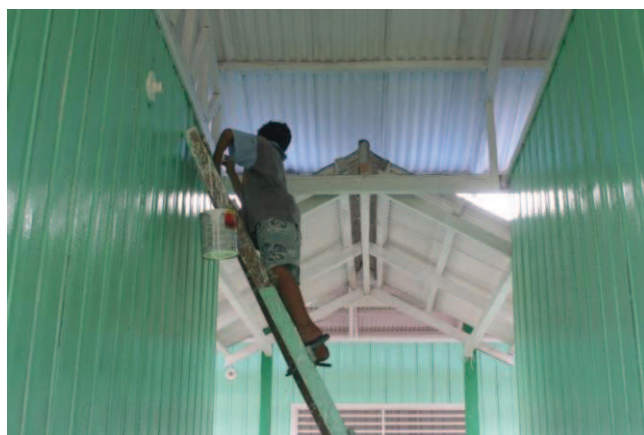
Figura 15. Constru o coletiva da nova escola da Comunidade de Isidoro.
