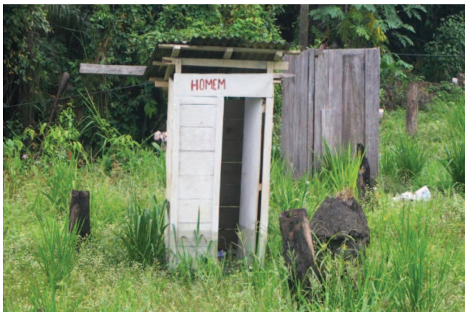
Figura 13. Banheiro em terra firme em Isidoro.
