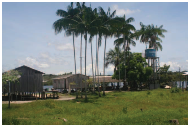
Figura 2. Vista geral da Comunidade de Isidoro (caixa d'água e poço artesiano).
