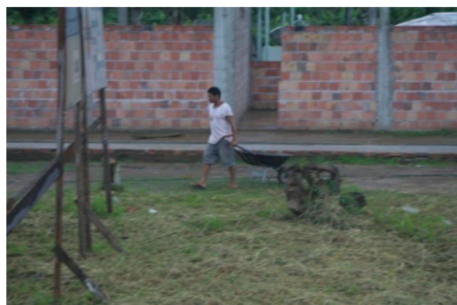
Figura 18. Trabalho individual do l der comunit rio na constru o da nova escola em Lauro Sodr .
